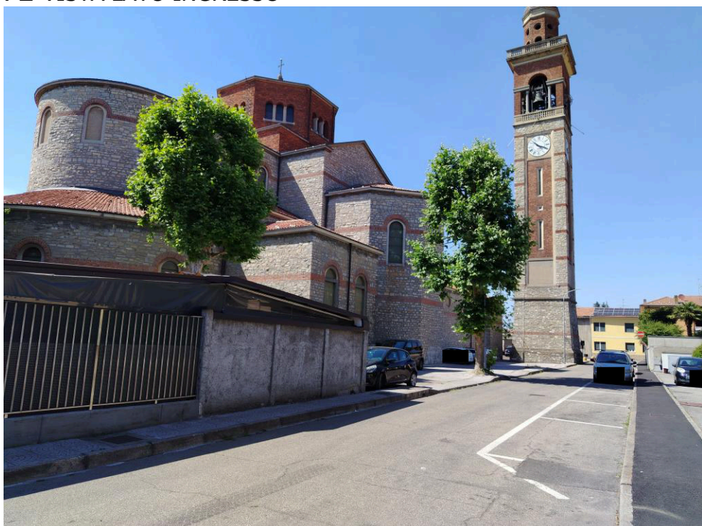
F2 VISTA LATO INGRESSO
